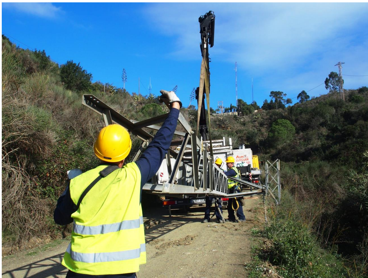
Retirada d'una línia elèctrica al Parc Natural de Collserola
